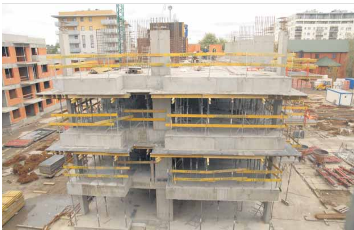
Budowa przy ul. Niedzielskiego
