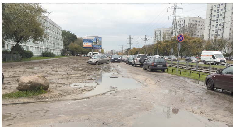
Czy powstanie w końcu droga dojazdowa z prawdziwego zdarzenia? Fot.: Marta Poniatowska
