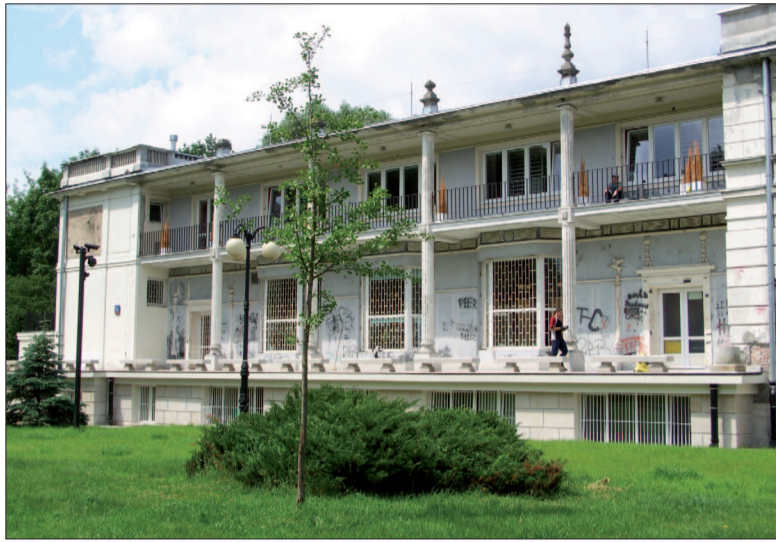
Remont elewacji planowany jest w tym roku. Fot. Bartłomiej Pograniczny
