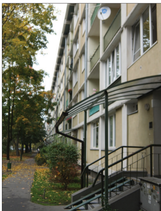
Dzięki nadbudowie lokatorzy w tym budynku będą mieli windy. Fot.: Wiktor Zajac
