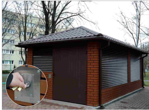
Nowe altanki z nowoczesnym systemem elektronicznym. fot. Bartłomiej Pograniczny
