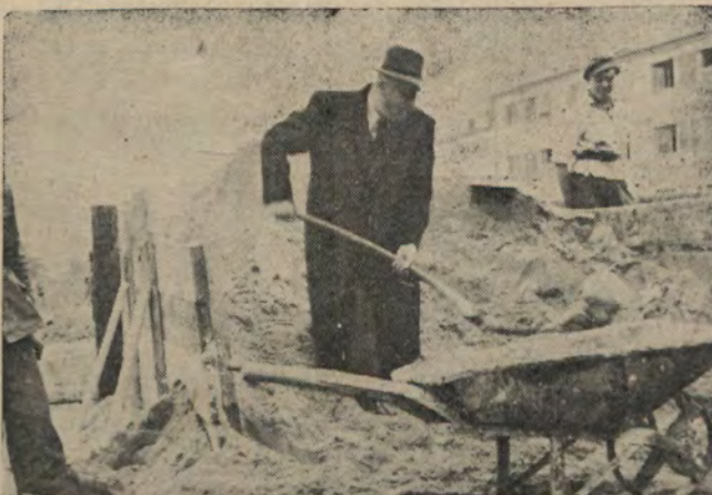
Min. Edward Osóbka-Morawski, b. mieszkaniec osiedla na Rakowcu, zgłosił się do pracy przy odbudowie Domu Społecznego wraz ze wszystkimi mieszkańcami. Obok niego syn — napełnia taczkę piaskiem
