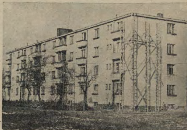
Dom w osiedlu na Bielanych podczas remontu.
