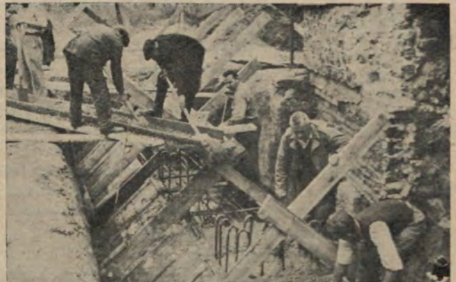
Betonowanie fundamentów pod słupy konstrukcyjne sali.
