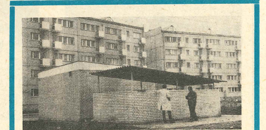
Śmietnik jak śmietnik — tylko ta przerwa pomiędzy ścianami a dachem obiektu. Nie wiemy czy projektantowi chodziło o efekt estetyczny czy o lepszą wentylację, wiemy, że w naszych warunkach klimatycznych dość częste są opady — deszcz, śnieg itp. Na razie, jak stwierdzają gospodarze kolonii na Rudawce i Al. Zjednoczenia, po każdym większym deszczu wnętrza śmietników zalewane są wodą, a przed nami zima z dodatkowymi atrakcjami w postaci śniegu, lodu itp. Niby drobiazg, ale pracy naszym gospodarzom nie ułatwia.
