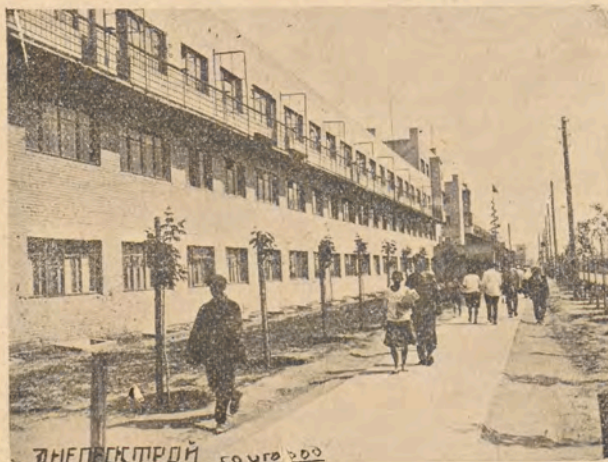
Osiedle Spółdzielcze w nowym mieście Zaporozu przy Dnieprogesie.
