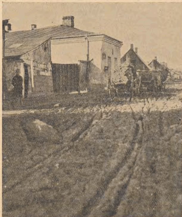
Oto, tak wygląda „dojazd“ do terenu budowy naszego nowego Osiedla na „Rakowcu“! W. S. M. dołoży wszelkich starań, aby nowe Osiedle uzyskało należyte połączenie z miastem.
