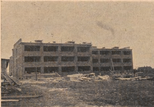
Dom jest pod dachem.
