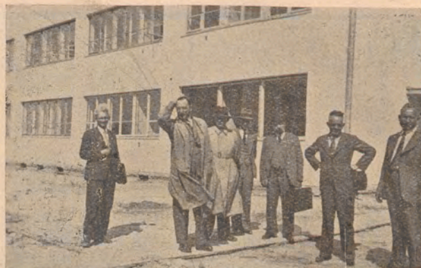
Komisja przyjmuje mieszkania wykończonych budynków na Rakowcu.
