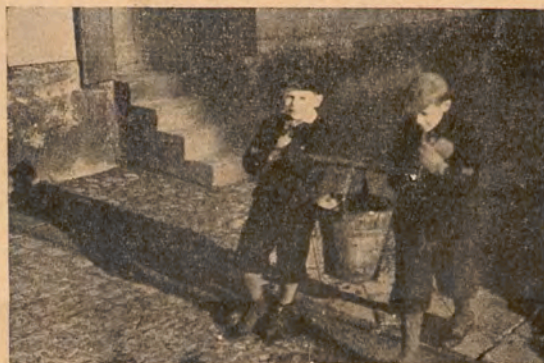
Gdy wodociąg jest drogi i niedostępny — pracują dzieci.
