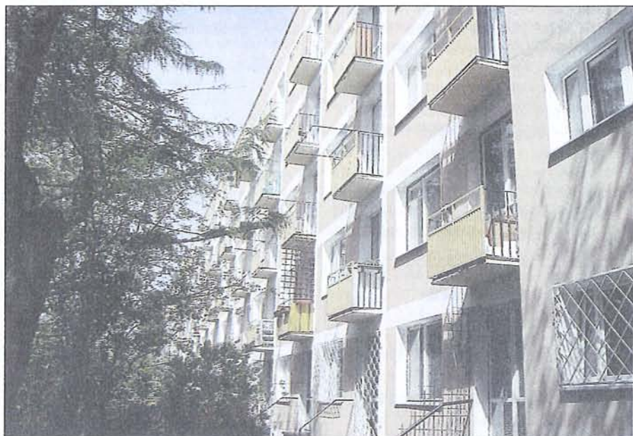
Tak prezentują się obecnie wyremontowane balkony w budynku przy ul. Broniewskiego 15A. Na stronie 1 zamieściliśmy zdjęcie tego budynku od frontu – specjalnie, żeby pokazać jak jest tam ładnie.
