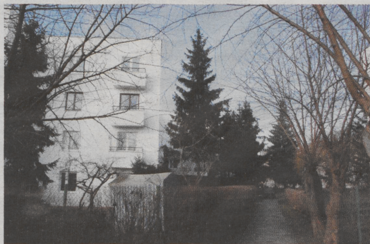
Osiedle Zatrasy. Niska zabudowa, rozległy teren, który musi być przypisany do każdej nieruchomości – to spowoduje, że i w tym osiedlu opłaty za wieczyste użytkowanie gruntów będą bardzo zróżnicowane.
