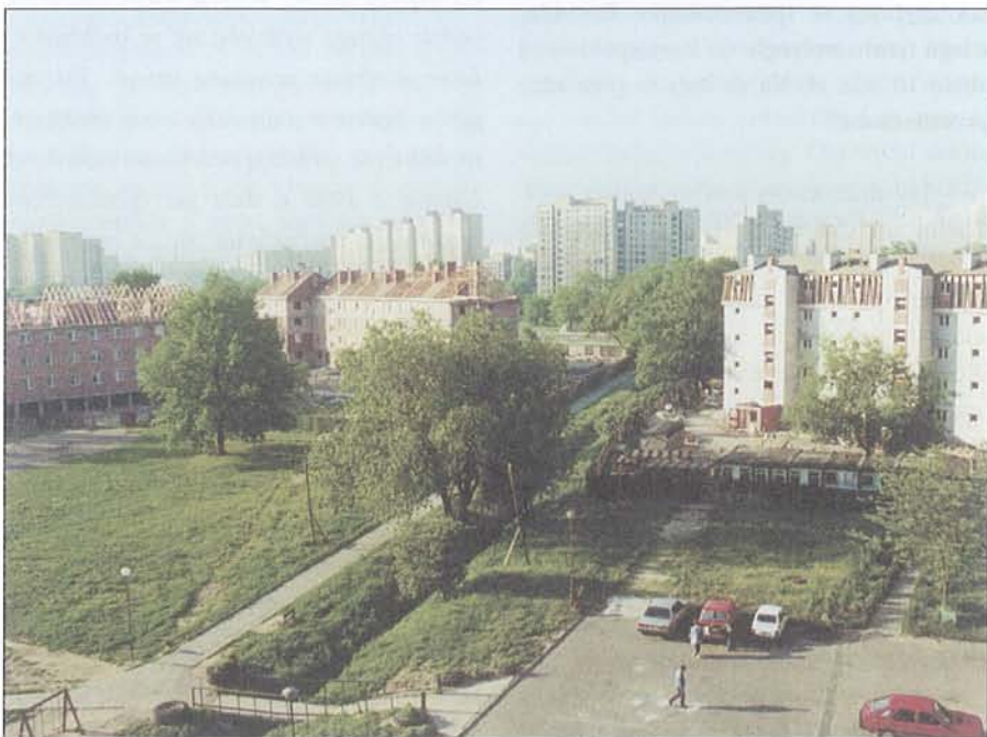
Fot. 2. Czerwiec 1997 r. Trwają prace budowlane.
