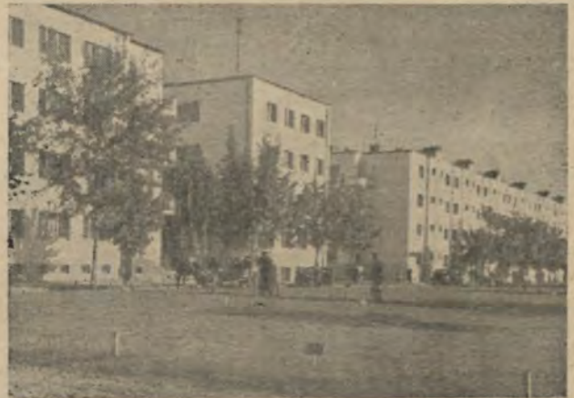
III i IV kolonia na Żoliborzu, dźwignięte z ruin
