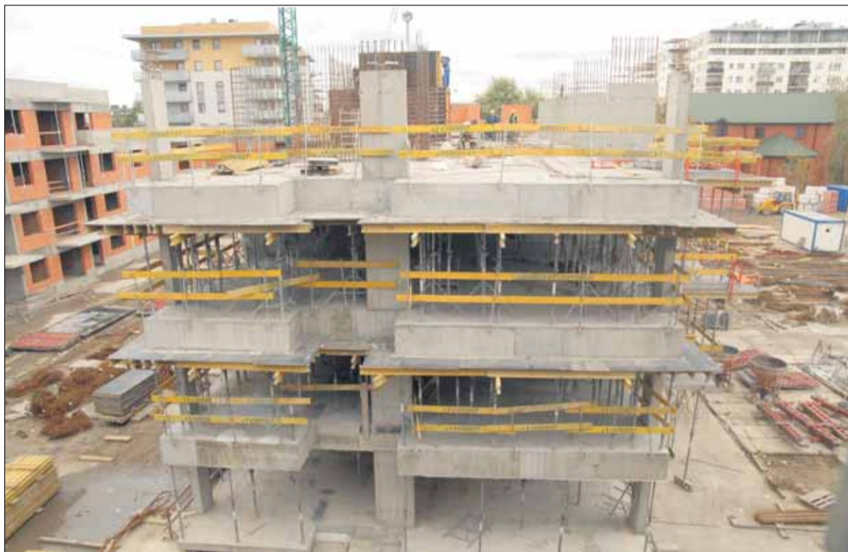
Budowa przy ul. Niedzielskiego
