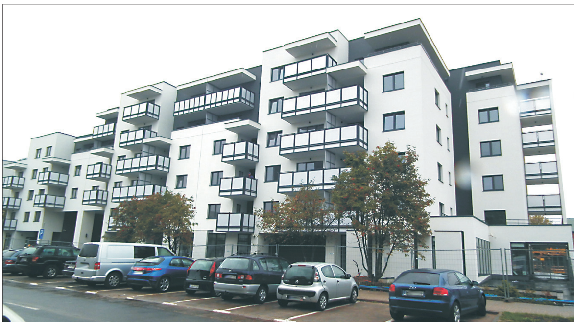
I etap inwestycji przy ul. Niedzielskiego został zakończony, czytaj na stronie 2
