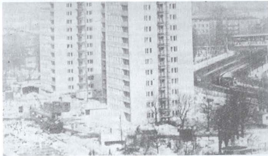
Styczeń 1967 r. Sady Żoliborskie - wielki plac budowy
