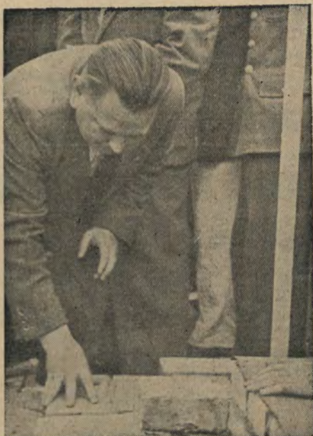
Prezes Zw. Zaw. Robotników Budowlanych Gwidon Kurzela solidnie wmurowuje ceglę.
