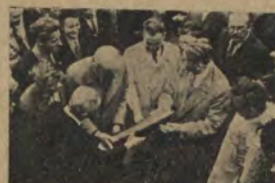
Przed zamurowaniem aktu
