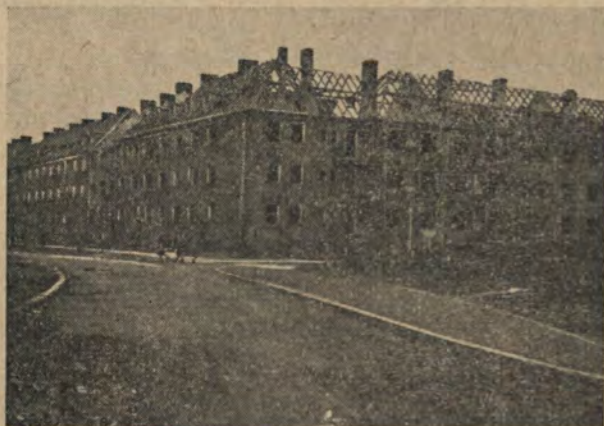
Osiedle Nr 2 — do odbudowy
