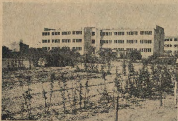
Osiedle na Rakowcu, bloki M — N w trakcie robót
