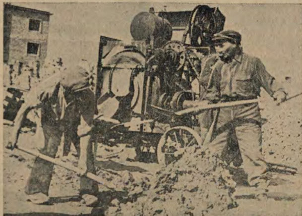
Betoniarka wyrabia gruzobeton pod ławy fundamentalne
