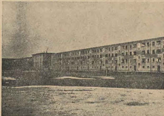
Osiedle Nr 1, blok Nr 5 i 6 — do odbudowy
