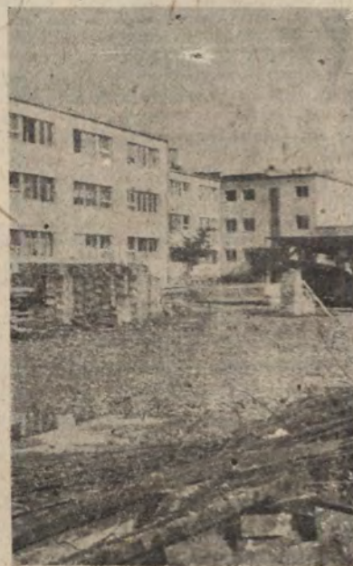
Stan obecny odbudowanej 1-ej części Osiedla Rakowieckiego
