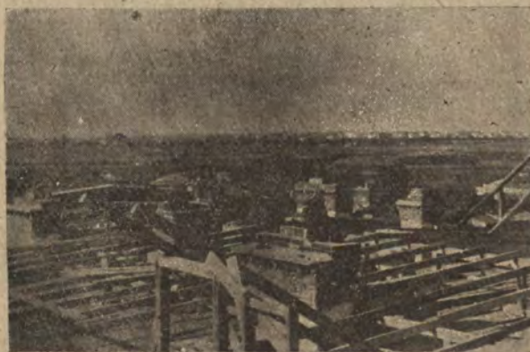
Wiązanie dachu na budynku F Osiedla Rakowieckiego
