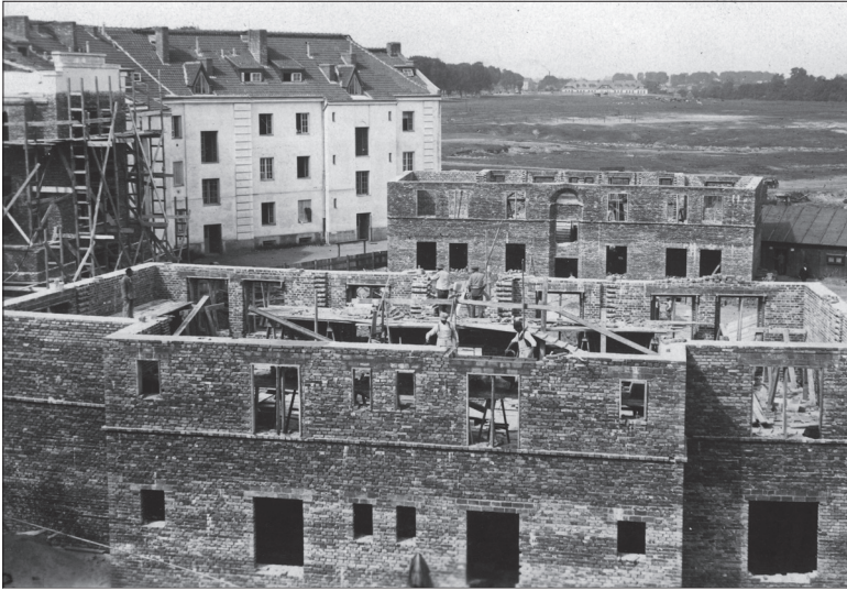
Budowa pierwszych kolonii WSM fot. autor nieznany (Archiwum Spółdzielni)
