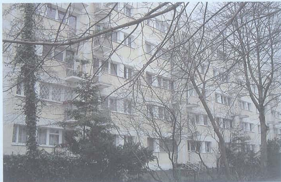
Nowa elewacja budynku w osiedlu „Żoliborz IV”.
