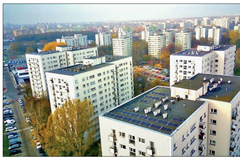
Mikroinstalacje fotowoltaiczne fot. Administracja Osiedla Żoliborz III
