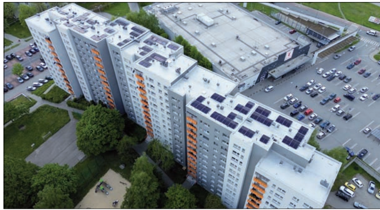
Dach jednego z budynków spółdzielni mieszkaniowej w Tychach
