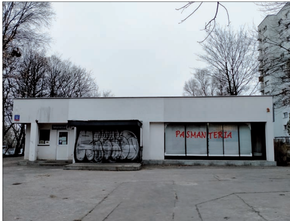
Elewacja budynku od strony południowej
