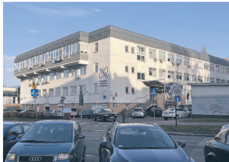
Przy siedzibie WSM miejsca parkingowe i postój taksówek do likwidacji?
