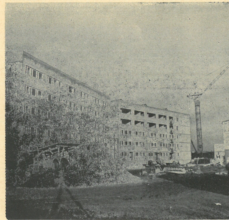
Budowa osiedla Rudawka. Fot. M. Wirkus
