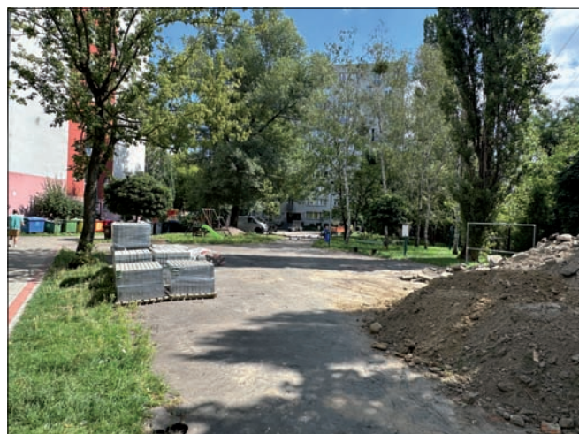
Kolonia Dymińska przed remontem fot.: Marcin Sosiński
