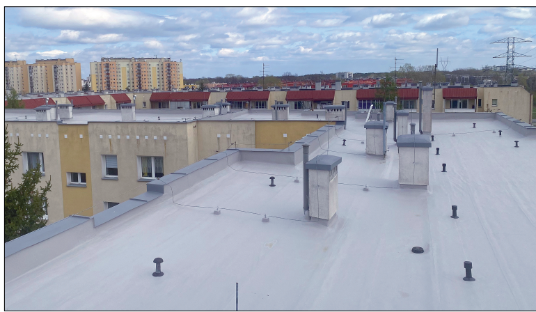
Dach Ciołkosza 2A po remoncie
